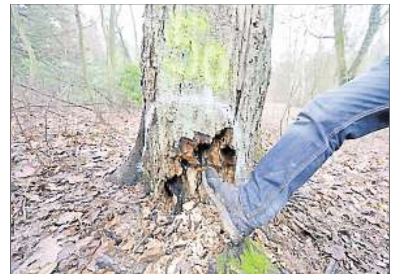
Dieser Baum leidet unter Stammfäule und steht nicht mehr sicher.
